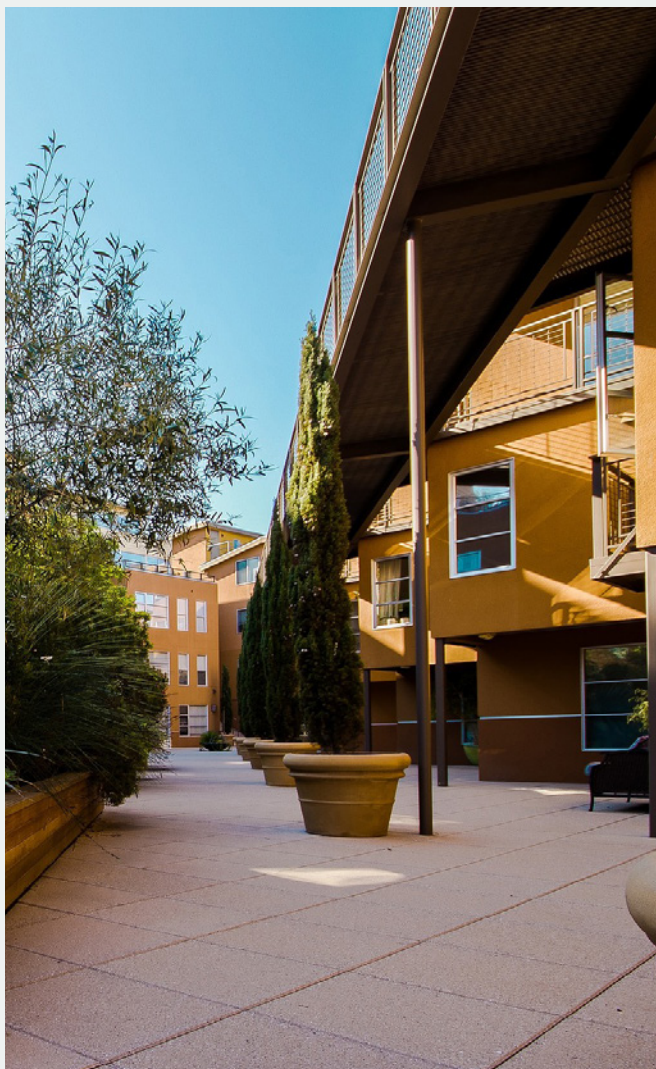
Ačkoliv bytové jednotky v přízemí postrádají balkon, mohou zase disponovat předzahrádkou. Foto redakce
